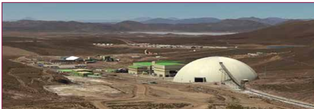
Gráfico 11. MSC: Domo que elimina la dispersión de polvo en la atmósfera
